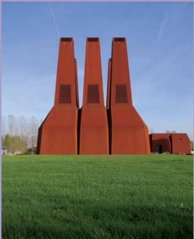
Een nieuwe WKK-centrale op De Uithof in Utrecht: esthetisch verantwoord en passend in de overige bebouwing. (foto: Atelier Zeinstra van der Pol BV)
