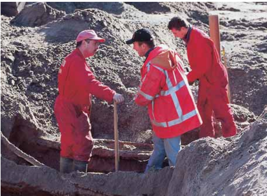
Het spitwerk is gedaan: kan de bouw of aanleg beginnen? (foto: Marcel Minnée)
