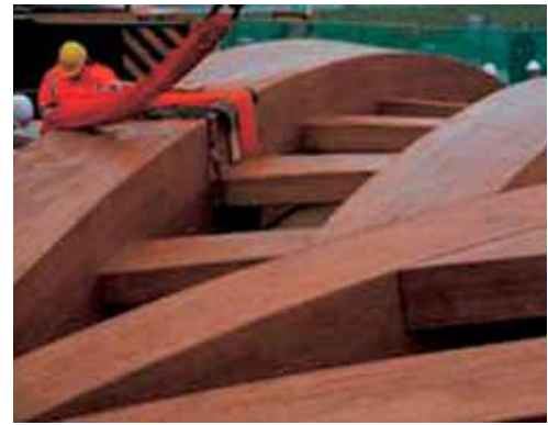
Fietsers- en voetgangersbrug uit Titan Wood bij Sneek.
